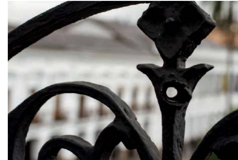
Rejas de hierro del Palacio con huellas de los disparos en la asonada de 1975.
